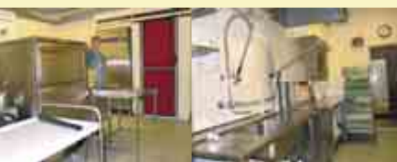
Keittiön muutostyöt valmiina palve- lukseen
