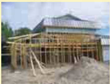
Monitoimihallin laajennustyö ihan mukavasti aikataulussa 4.6.2005.
